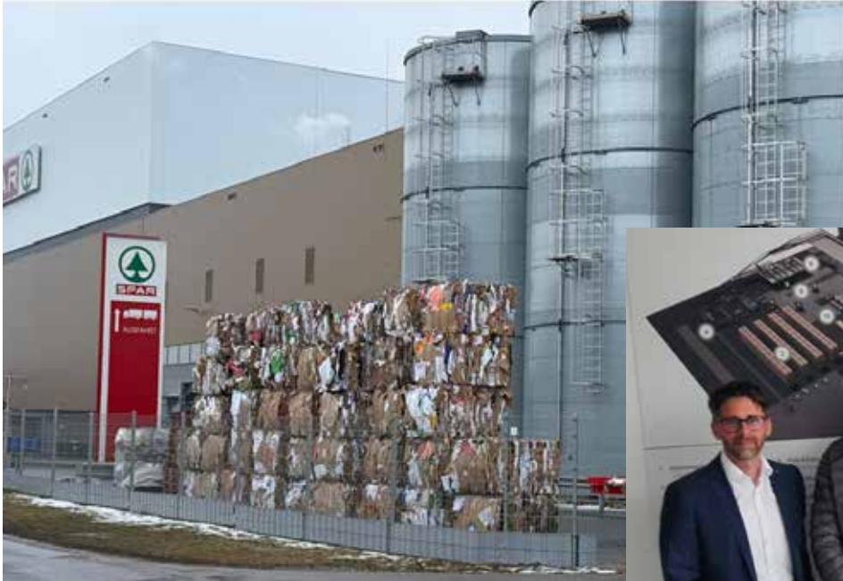
Mülllagerungen am Areal des Logistikzentrums: Durch den Wind wird der gepresste Müll aufgrund des zu niedrigen Zauns in die umliegende Umgebung verblasen.
