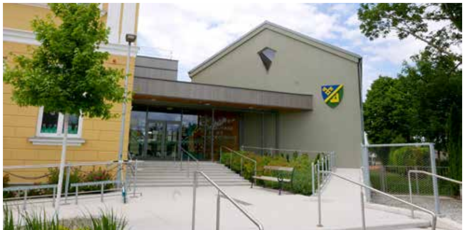
Neuer Zubau Volksschule Moosbrunn.
