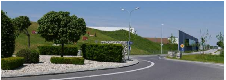
Erdwall als Sicht- und Schallschutz
